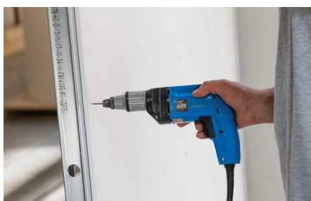
Vissage des plaques Knauf HydroProof®
