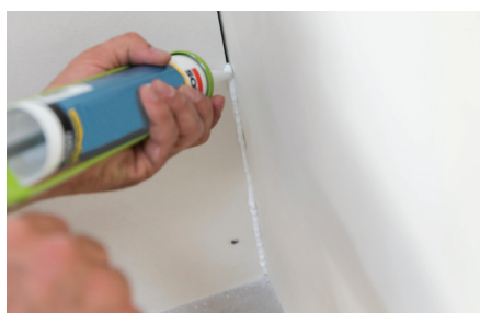
Traitement des angles et points singuliers à l'aide d'un mastic sanitaire label SNJF
